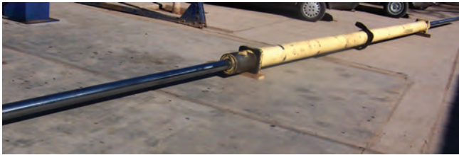
REPARACIÓN DE CILINDRO PULL DOWN
